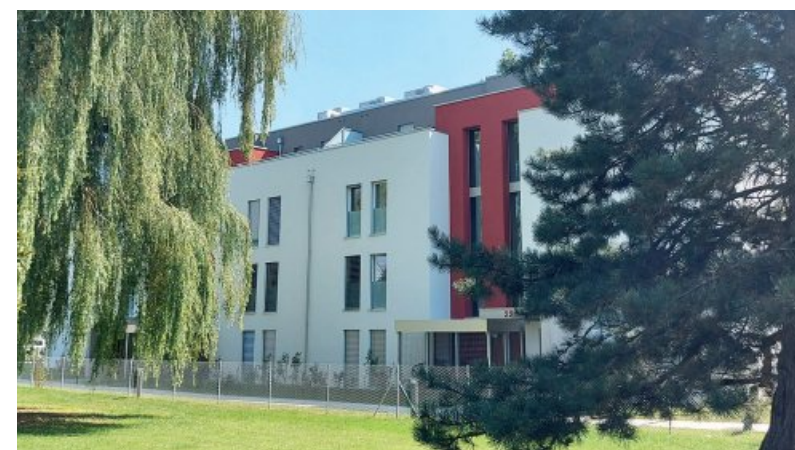
Lotissement « Les Jardins de Rozon » à Bardonnex (GE)
